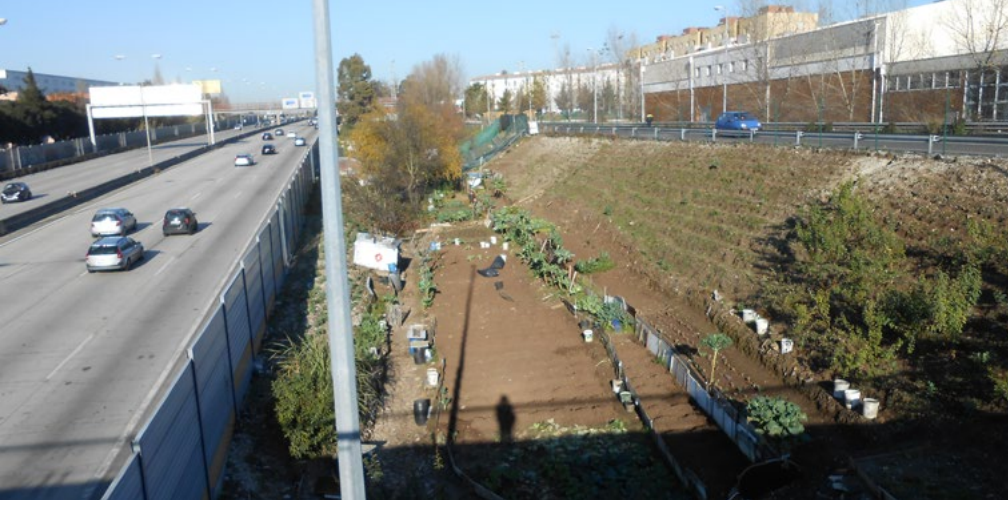
図4 – インフラの近くにある自然発生的なガーデン(ポルトガル、リスボン)。写真: Teresa Leitão
