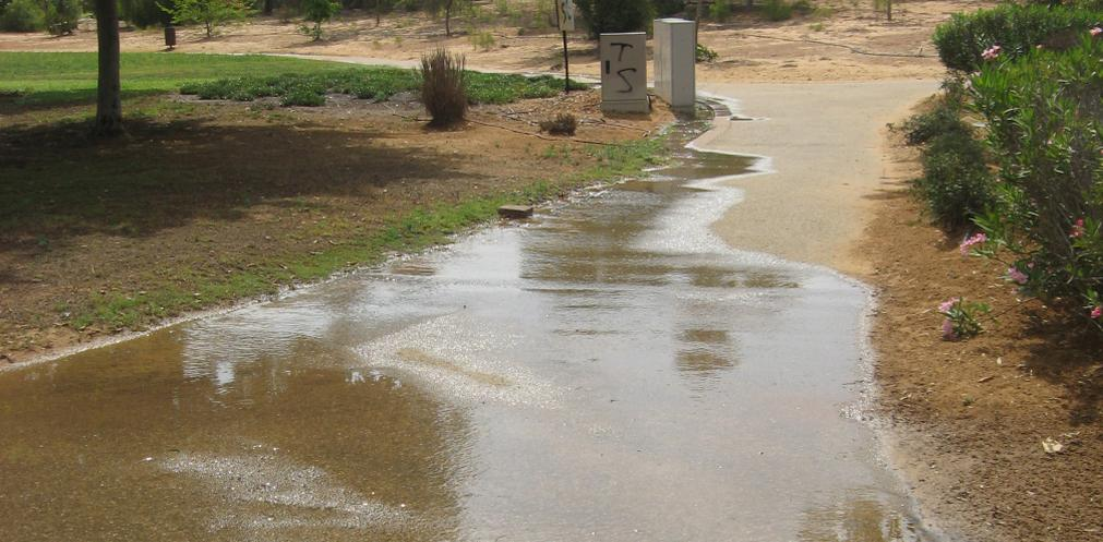
Image 2 - Engorgement du sol dû à un dimensionnement ou à une mise en oeuvre inadéquate du système d'irrigation dans une zone pentue. Photo: Avigail Heller.
