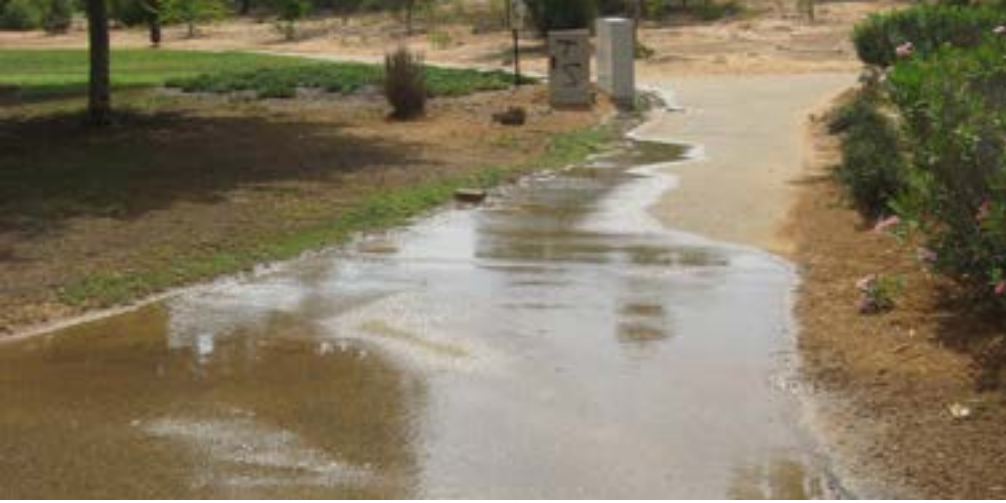
Fig 2 - Perdite di acque dovute ad un inadeguato progetto o una scorretta gestione dell'irrigazione su terreno inclinato. Foto: Avigail Heller
