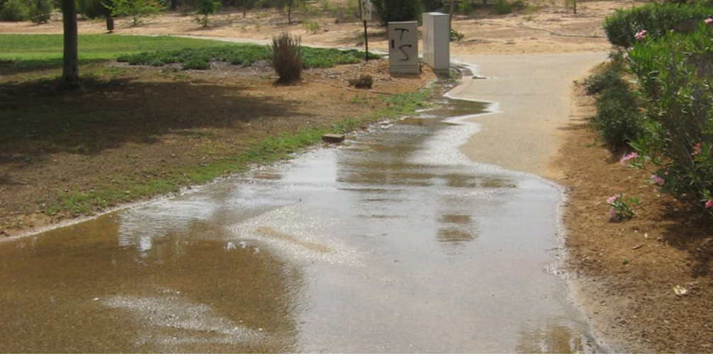
図2 - スロープでの灌漑システムのデザインや運用の不十分さに起因する浸水。写真: Avigail Heller
