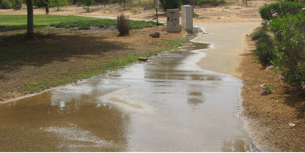
Foto 2 – Wateroverlast als gevolg van gebrekkig ontwerp en/of functioneren van een irrigatiesysteem op een helling. Foto: Avigail Heller
