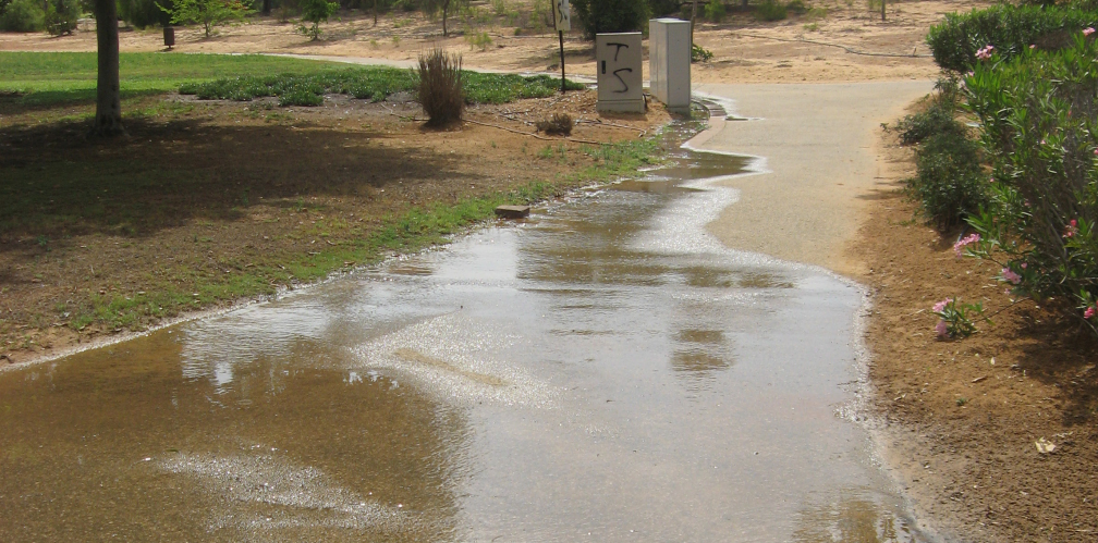
Obrázok 2 – Stojaca voda v dôsledku nevhodného dizajnu a/alebo inštalácie závlahového systému vo svahu. Foto: Avigail Heller
